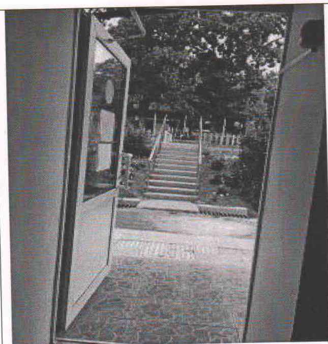
Фото № 7 Дверь входная. Правый вход
