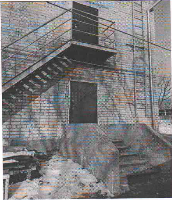
Фото № 17 Эвакуационные выходы с 1 и 2 этажей (левое крыло).
