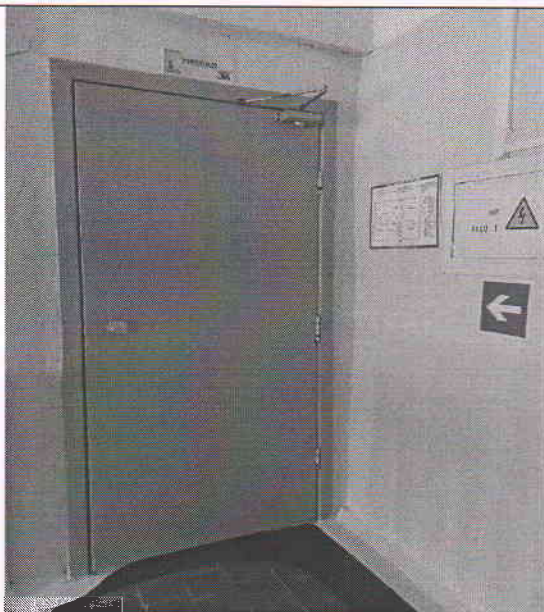
Фото № 15 Эвакуационный выход спортзал
