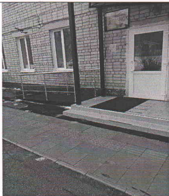
Фото № 3 Лестница, пандус. Правый вход
