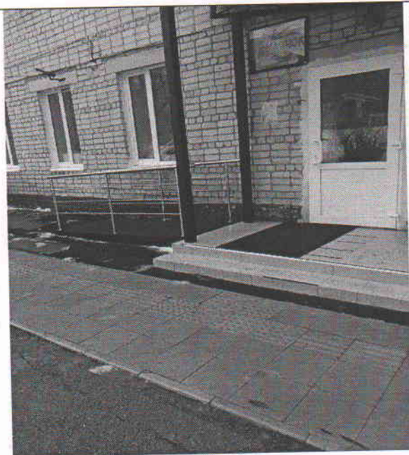
Фото №3 Лестница, пандус. Правый вход
